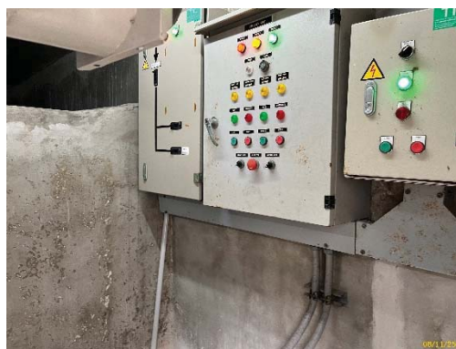
ตู้ควบคุมระบบปั้มน้ำใช้
