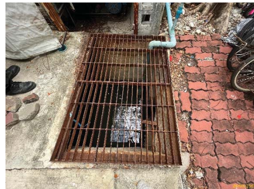
บ่อพักน้ำสุดท้ายพร้อมตะแกรงดักขยะ
